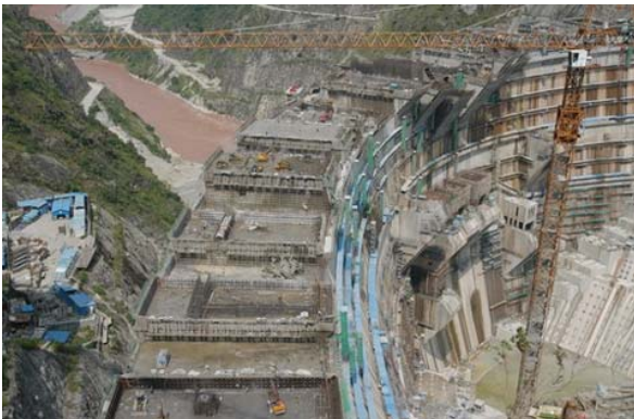
Đập Xiaowan đang được xây cất (Ảnh: Sinohydro)
